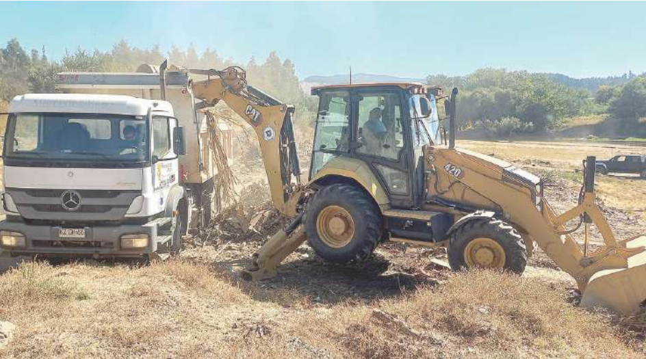
Se trabajó con camiones tolva, retroexcavadora y un minicargador.
