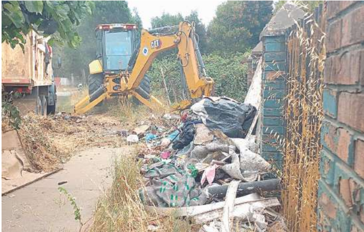
Trabajos de limpieza en la calle Austria, en el sector de la Ex Calán.
