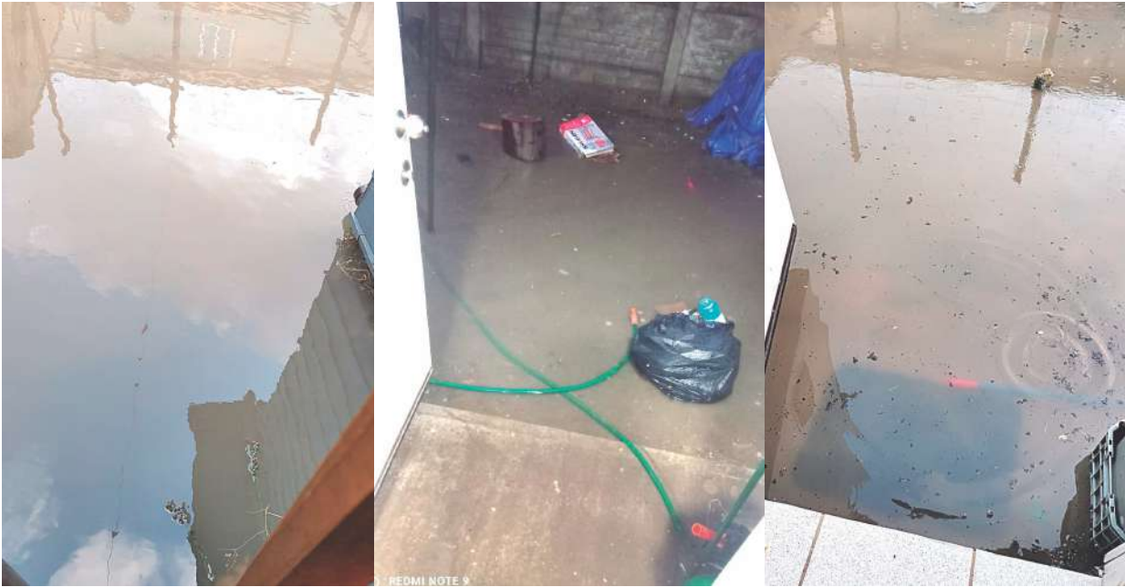
Al menos 15 viviendas se vieron afectadas en sus patios, con alto riesgo de que el agua entrara a sus casas.
