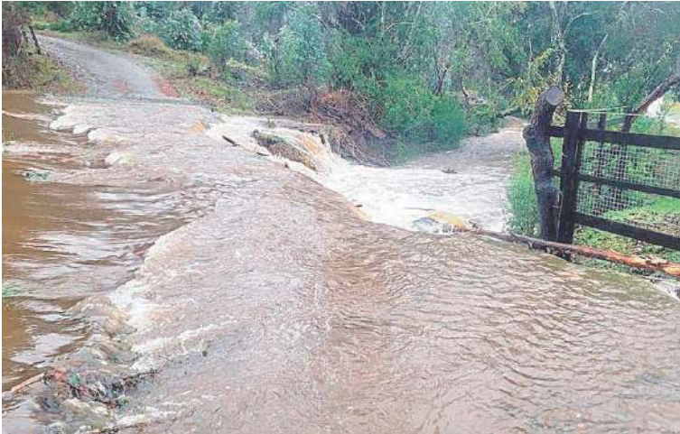
Los desbordes de río y canales afectaron a diversas comunas de Malleco.
