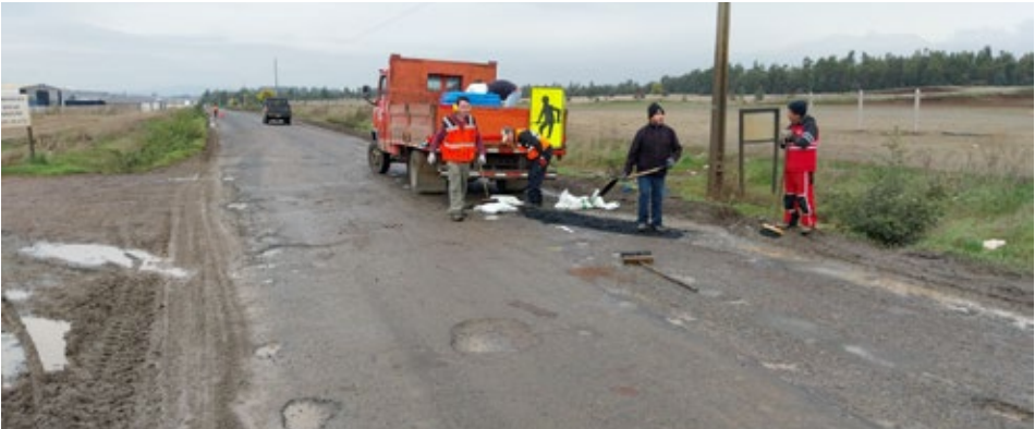
Trabajadores de Vialidad iniciaron labores de reparación en la ruta.
