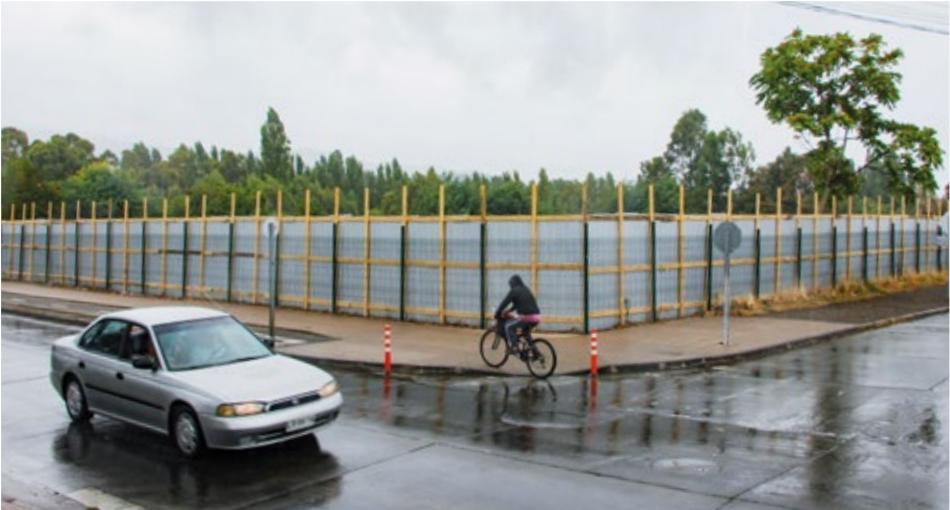
La empresa que construirá el strip center ya está instalada e inició la obras. Para ello levantó un cierre perimetral en el terreno.
