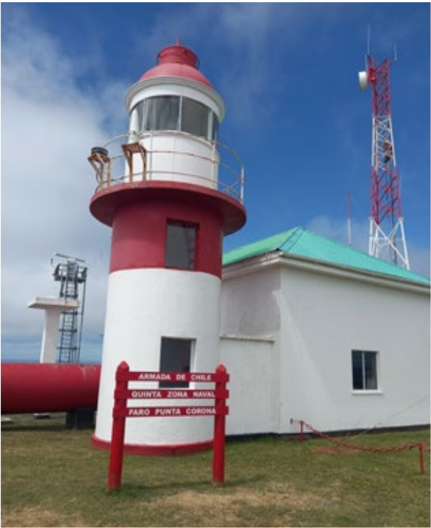
El Faro Punta Corona ubicado al noroeste de la Isla Grande de Chiloé.
