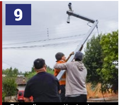
Fotografía reparación de cámaras.
