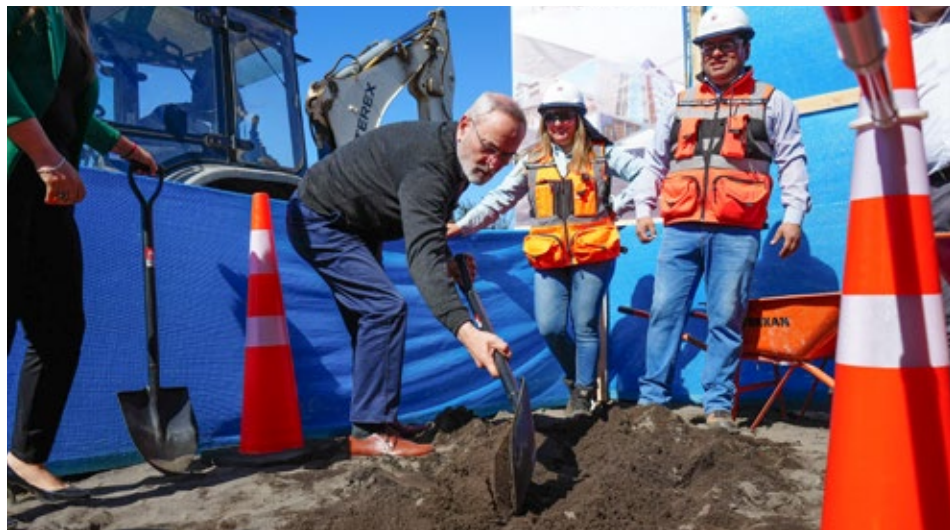
Las autoridades encabezaron la colocación de la primera piedra de la obra en Renaico.
