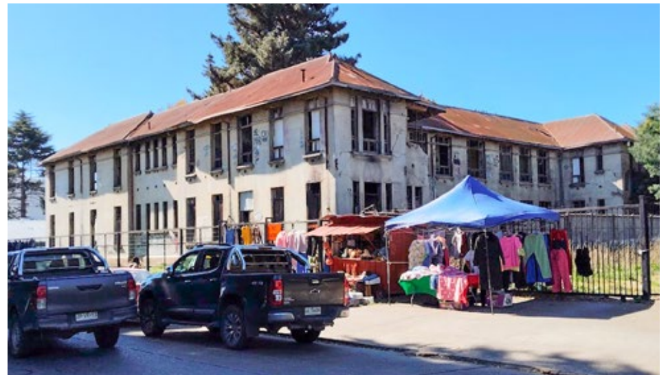
El antiguo edificio del Hospital Viejo espera su mejoramiento para recibir las dependencias de la Biblioteca Municipal de Angol.
