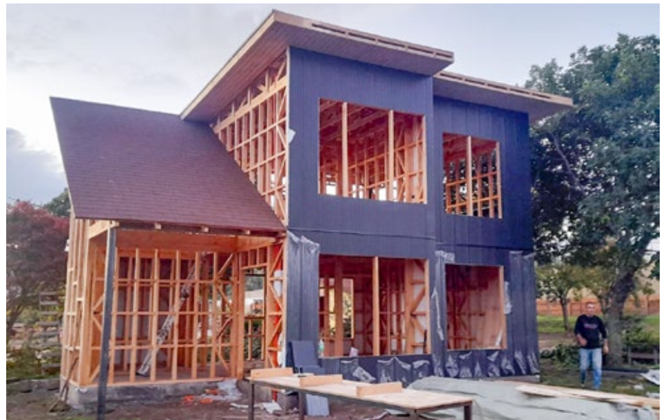
Diversas obras realiza la empresa Trarum en parcelas de la provincia de Malleco y La Araucanía.
