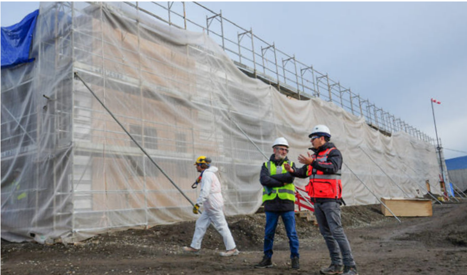
De acuerdo con la planificación vigente, la construcción del nuevo Cesfam Huequén debería concluir en septiembre de 2027.
