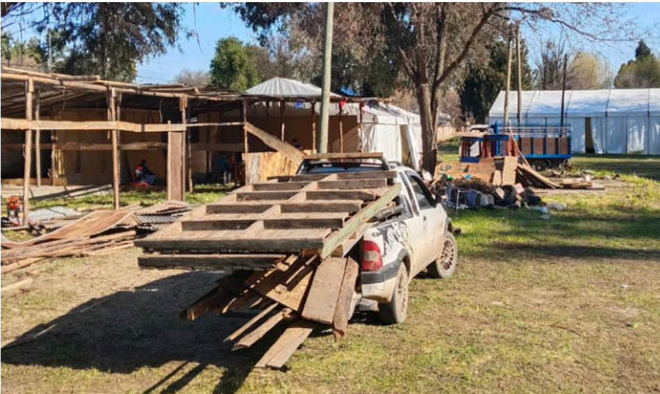
Avanzan los trabajos de construcción y habilitación de las ramadas en el recinto Sama de Angol, donde los locatarios afinan los últimos detalles para la inauguración programada para el jueves 17 de septiembre.
