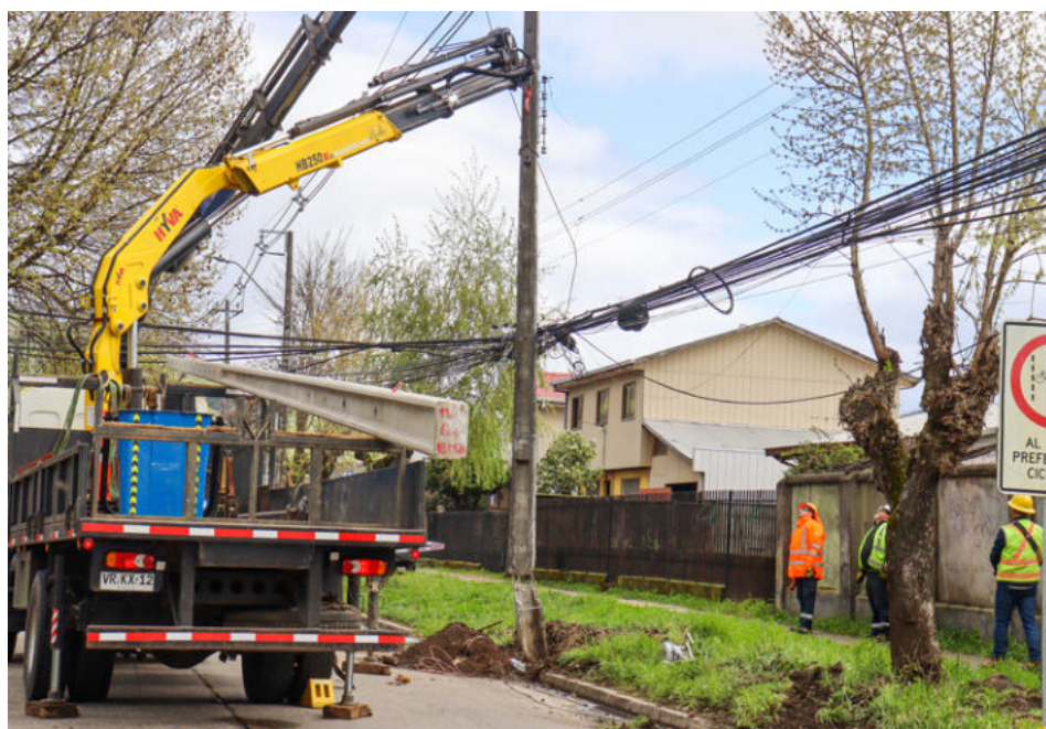
Trabajadores de una empresa contratista de Frontel efectuaron el cambio del poste dañado.
