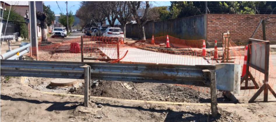
Trabajos de intervención de redes de agua potable se ejecutan en el sector de Bunster con Colhue, donde se mantienen sectores de la vía intervenidos por las faenas.
