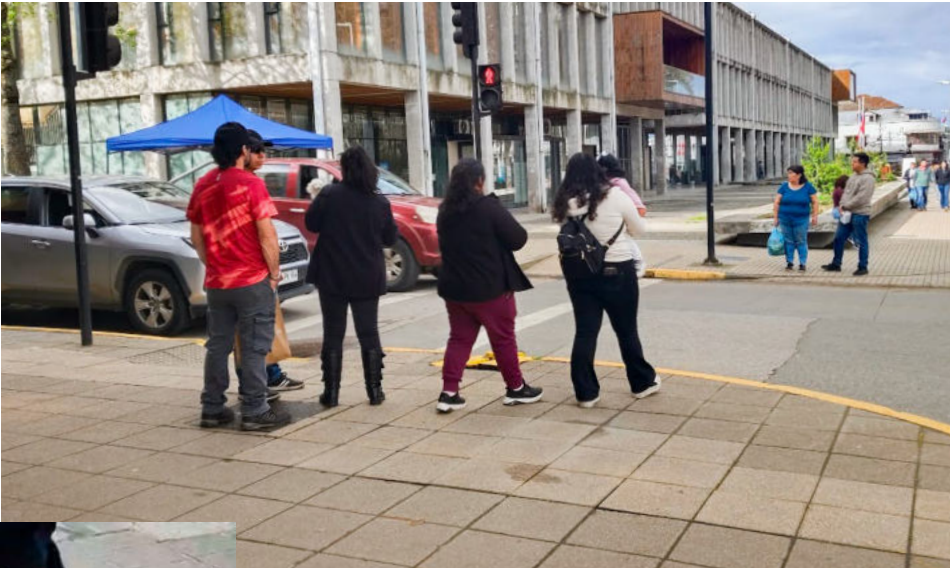
En la esquina de Lautaro con Manuel Bunster, donde se ejecutaron trabajos de reposición de la red de agua potable y posteriormente se levantaron baldosas, lugar en que una niña sufrió una caída.
