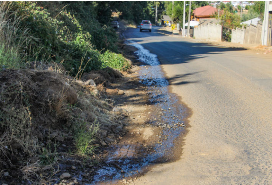
Aguas servidas escurren a un costado de calle en Las Acequias, reflejando las precarias condiciones sanitarias que enfrentan familias que aún esperan una solución definitiva a la falta de alcantarillado en Angol.
